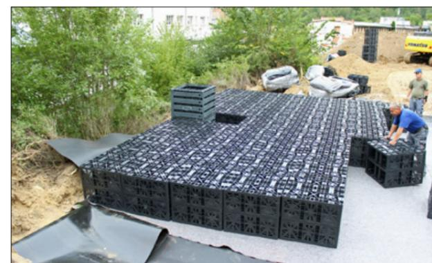
Für das Bauvorhaben wurden die Module innerhalb von nur zwei Arbeitstagen vor Ort zu einem vierlagigen Blockverbund montiert.
