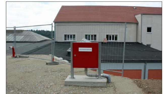
Die Stützen für die Einspeisung und die Entnahme des Löschwassers wurden nach der Geländemodellierung installiert.
