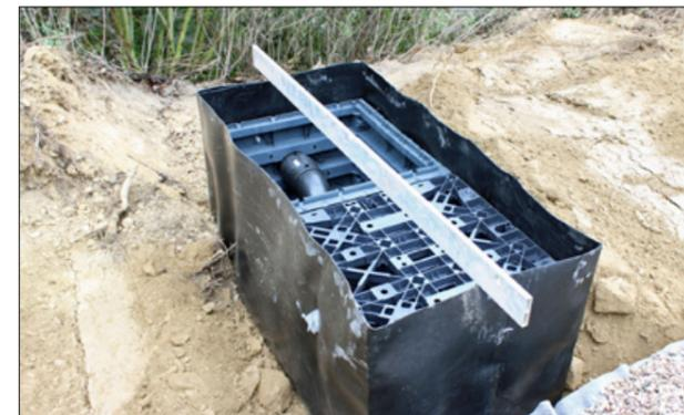
Die Schächte wurden bei GRAF bereits projektspezifisch vormontiert und anschlussfertig angeliefert. Dies sparte Zeit beim Einbau und erleichterte die Inbetriebnahme vor Ort.
