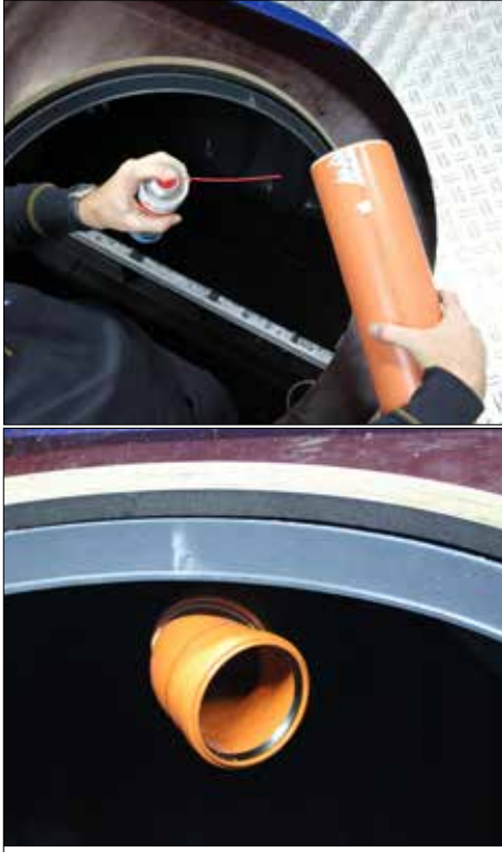
- Einbau des Ablaufrohres
