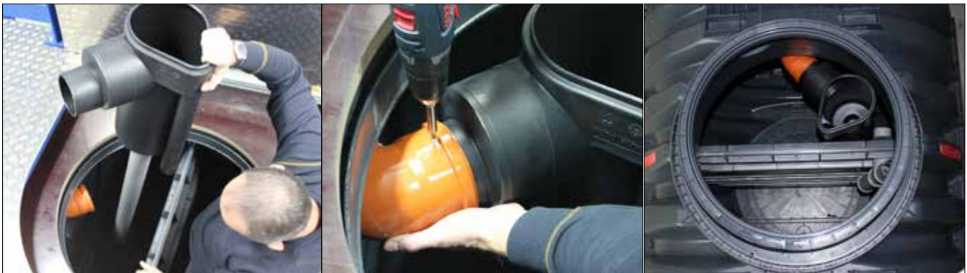
- Einsetzen der Probenahme mit dem Stützfuß
