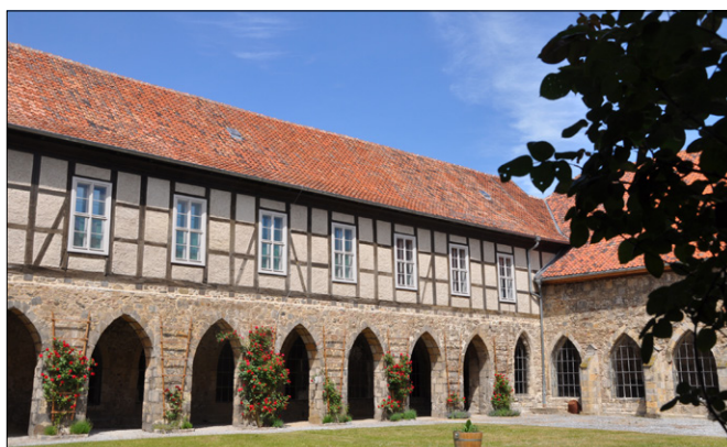
In den vergangenen Jahren konnte durch umfangreiche Sanierungs- und Neubaumaßnahmen der Zustand des Klosters Michaelstein für die kulturelle und touristische Nutzung wesentlich verbessert werden. (Foto: Kulturstiftung Sachsen-Anhalt)
