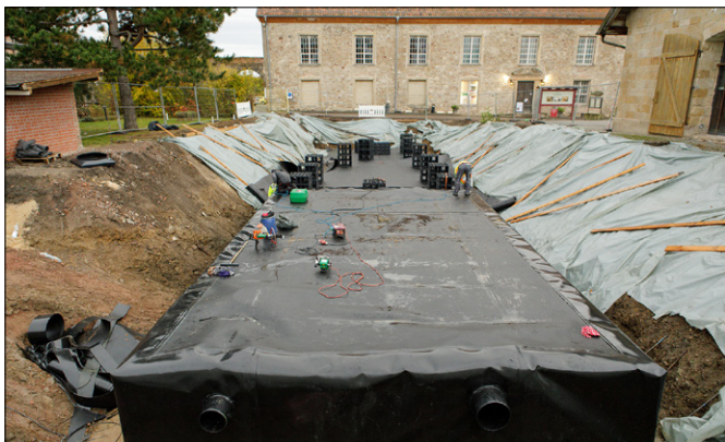
Der aus GRAF EcoBloc Inspect Modulen hergestellte Blockverbund wurde mit einer Kunststoffdichtungsbahn eingeschweißt. (Foto: GRAF)
