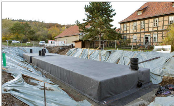
In einem dritten Arbeitsschritt wurden die Behälter mit dem Geotextil umschlossen. (Foto: GRAF)
