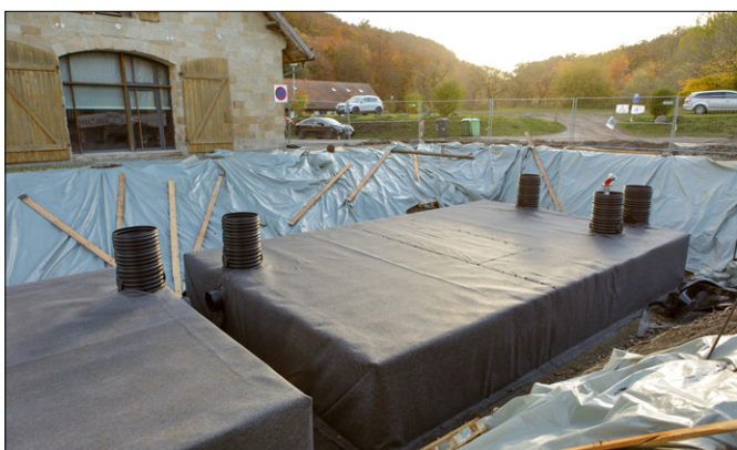
Die Schächte wurden bei GRAF bereits projektspezifisch vormontiert und anschlussfertig angeliefert. Dies sparte Zeit beim Einbau. (Foto: GRAF)
