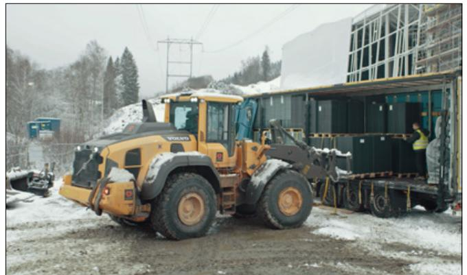
Das GRAF EcoBloc Inspect smart Modul lässt sich platzsparend ineinander stapeln und reduziert das Transportvolumen zum Einbauort. (Foto: GRAF)
