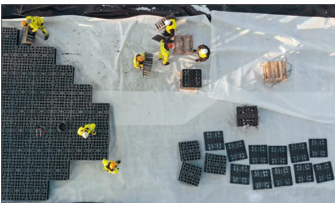
In nur 210 Arbeitsstunden haben sechs Mitarbeiter vor Ort 4.080 GRAF EcoBloc Inspect smart zu einem Blockverbund montiert und die Folien eingeschweißt. (Foto: GRAF)
