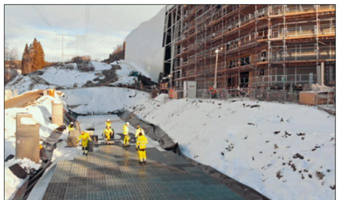
Das Rückhaltebecken wurde in den felsigen Grund mit einer Erdüberdeckung von bis zu 2,76 m unter der Parkfläche eingebaut. (Foto: GRAF)
