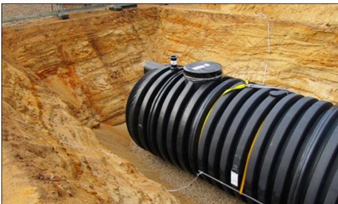
Alle für die Löschwasserentnahme notwendige Technik ist bereits im Lieferumfang enthalten und vormontiert.
