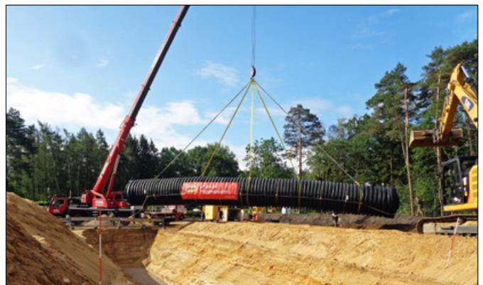
An den bereits vormontierten Halteschlaufen hob der 60-t-Kran den 25,12 m langen und 2,50 m im Durchmesser großen Tank ein.
