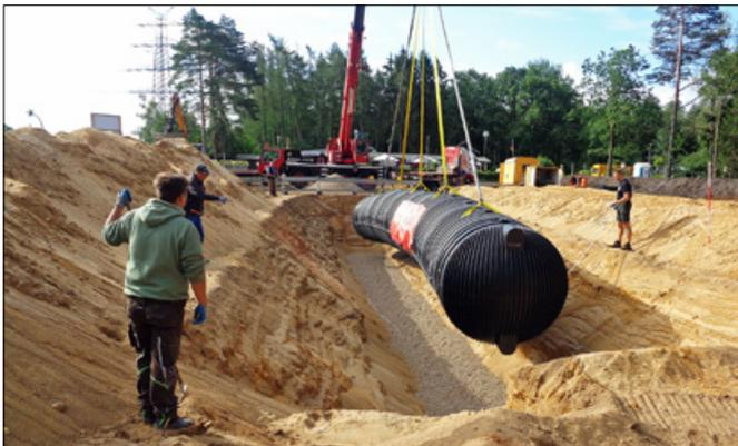
Mit viel Fingerspitzengefühl an der Fernsteuerung wurde der Erdtank exakt in die Grube gehoben.
