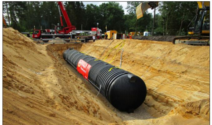
In einer Sohllentiefe von 3,75 m ist der Tank und einer Erdüberdeckung von 1,20 m ist der Löschwasserbehälter frostsicher eingebaut.
