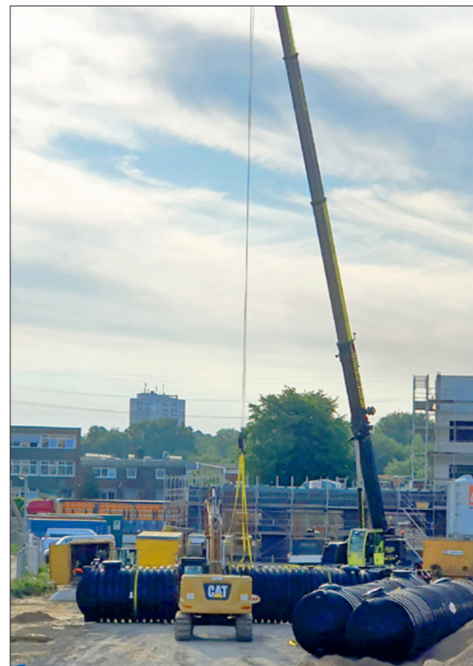
Die vier Kunststoffbehälter wurden mit einem Autokran eingehoben.*
