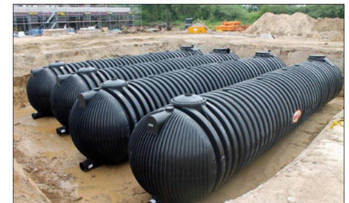
Die vier Behälter wurden für eine gleichmäßige Entnahme und Befüllung mit KG-Rohren DN 300 verbunden.*
