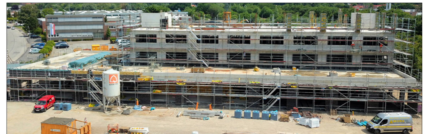
Im Januar 2020 wurde mit dem Bau des dreigeschossigen Gebäudes mit Ausstellungs- und Büroflächen für 130 Mitarbeiter begonnen. Dieses wird im März 2021 bezogen.*
