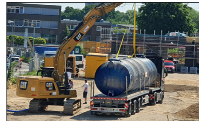
Die Löschwasserbehälter wurden mit einem Schaufelbagger an den mitgelieferten Halteschlaufen entladen.*
