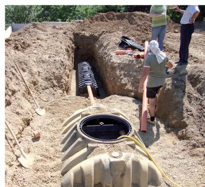
Depuradora con túneles de infiltración. 9HE
