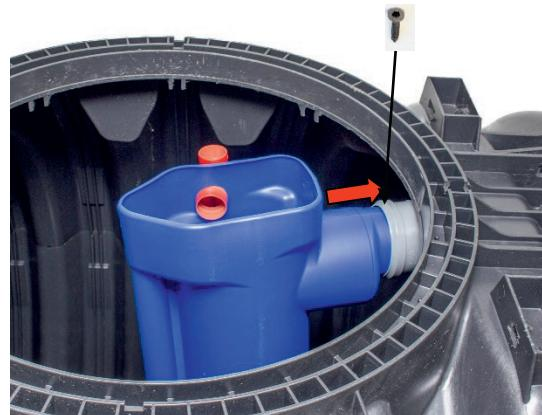
Der Auslaufstutzen der Probeentnahme wird in die Muffe des Auslaufrohrs gesteckt (Gleitmittel verwenden!). Die Muffen-Verbindung ist mit einer Spax-Schraube zu sichern.
