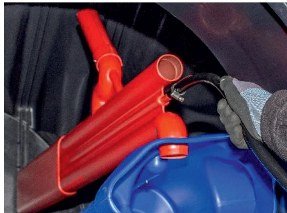
Luftschlauch (13mm) am Klarwasserheber anschließen.
