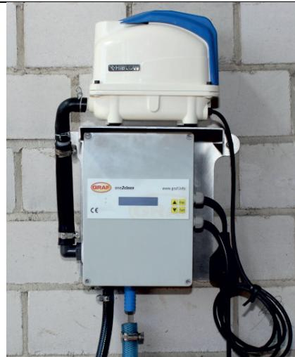
Las mangueras de aire se conectan en las boquillas inferiores de la unidad de control.
