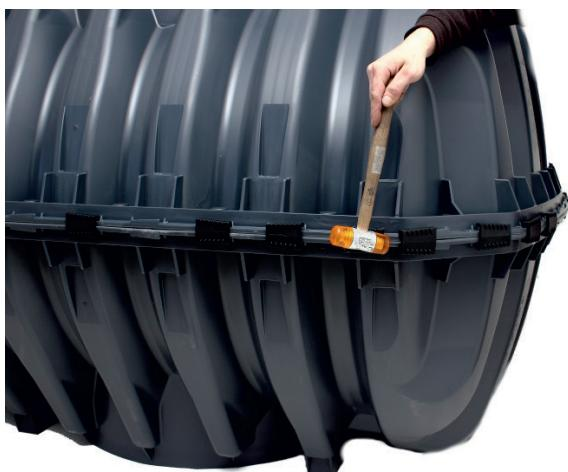
Klemmen zur Verbindung der Ober- und Unterschale montieren.
