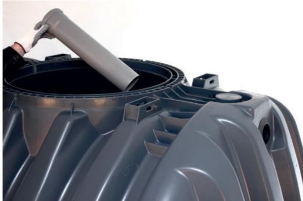
Pousser le tuyau d'évacuation de l'intérieur à travers le joint.
