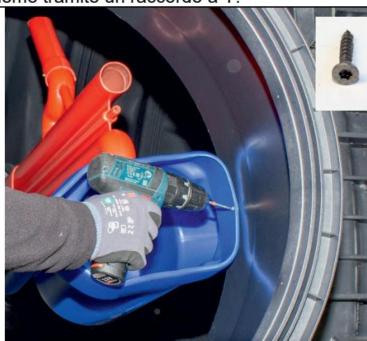
Fissare il contenitore per il campionamento alla torretta del serbatoio utilizzando una vite Spax.
