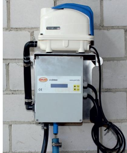
Collegare i tubi di aerazione ai portagomma della centralina. Per il montaggio consigliamo di riscaldare le estremità dei tubi flessibili.
