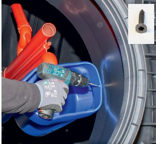
Probeentnahmehräuber mit Spax-Schraube am Tankdom befestigen
