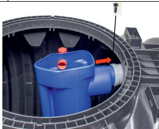
El tubo de extracción de la toma de muestras se conecta al tubo de salida (¡usar lubricante!). Asegurar la unión con un tornillo Spax.
