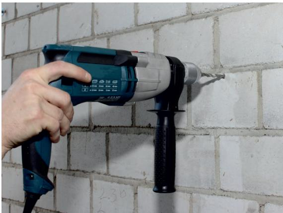
La centralina deve essere installata in un locale chiuso, asciutto e privo di polvere. Per il montaggio è necessario eseguire due fori da 8 mm nella parete.
