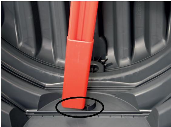
Il sollevatore viene inserito dall'alto nella scanalatura del serbatoio Carat.
