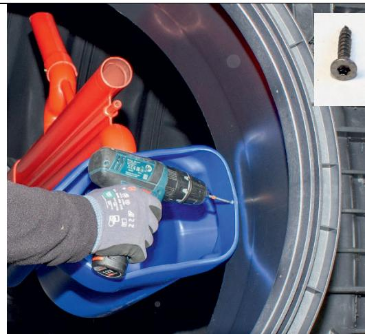
Fijar el depósito de la toma de muestra a la cúpula con tornillo Spax
