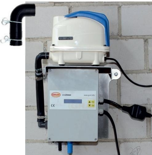
Il compressore viene posizionato sopra la centralina. Per il collegamento dell'aria utilizzare il gommito in gomma. Collegare la spina del compressore alla presa della centralina.
