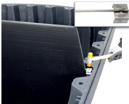
Con un tondino infilare i ganci di fissaggio nella parete sommersa e incastrarli saldamente con un martello.
