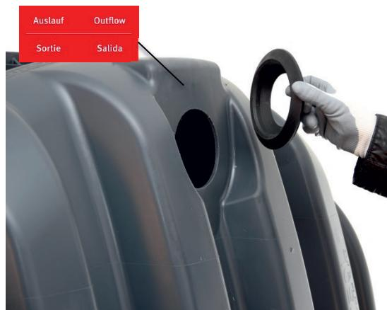
Bohrung entgraten. Lippenabdichtung DN 110 einsetzen. Beim Ablauf muss die Durchführungsrichtung von innen nach außen sein. Aufkleber „Ablauf“ aufkleben.
