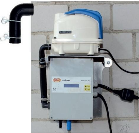
El compresor se monta encima de la unidad de control. Conectar el compresor a la unidad de control utilizando la manguera con codo de 90 grados y asegurándola con las abrazaderas incluidas. El enchufe del compresor se conecta en el conector hembra de la unidad de control.
