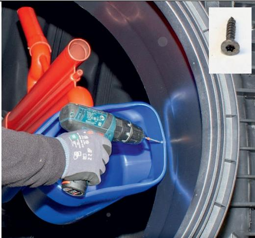
Fixer le récipient de prélèvement d'échantillons au dôme du réservoir avec une vis fournie.
