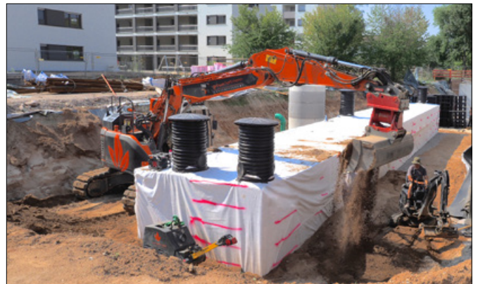
Die Grube wurde mit dem Aushub, einem Sand-Kies-Gemisch, verfüllt. (Foto: GRAF)
