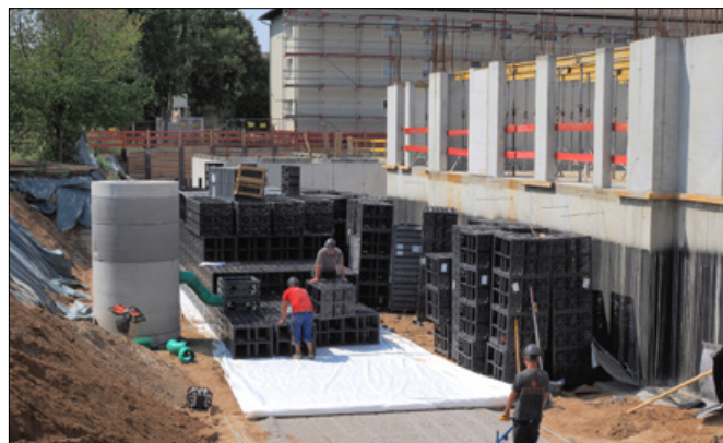
Der Einbau der Versickerungsanlage war recht einfach zu bewerkstelligen, da bereits beim Aushub für das Kellergeschoss der zusätzliche Bauraum für die Rigolen ausgehoben wurde. (Foto: GRAF)
