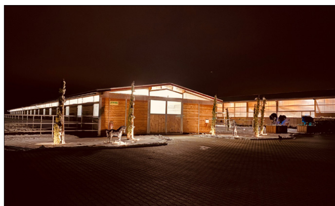
Die Dachflächen des Stallgebäudes werden in einen Regenwassertank von GRAF entwässert. (Foto: Grey Stone Ranch)
