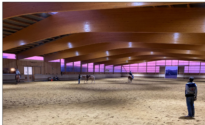
Die Reithalle der Grey Stone Ranch ist sehr großzügig bemessen. Die Dachflächen werden in einen Regenwassertank von GRAF entwässert. (Foto: Grey Stone Ranch)
