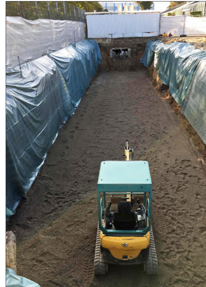
Vor dem Einsetzen der Tanks wurde in 3,5 m Tiefe das Kiesbett angelegt.
